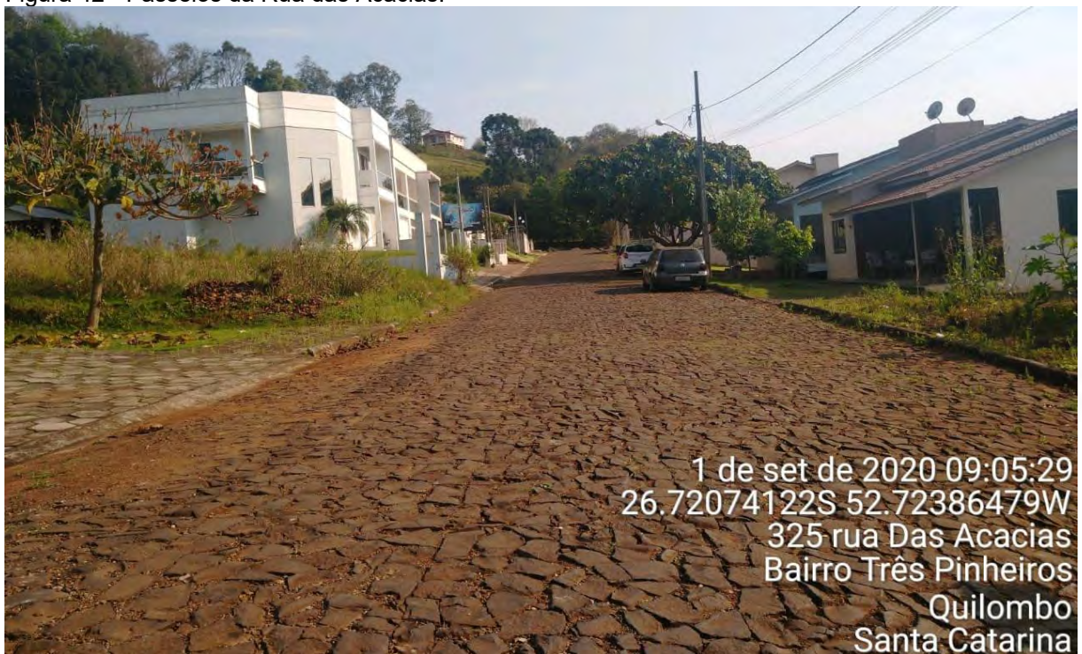
Figura 42 - Passeios da Rua das Acácias.
