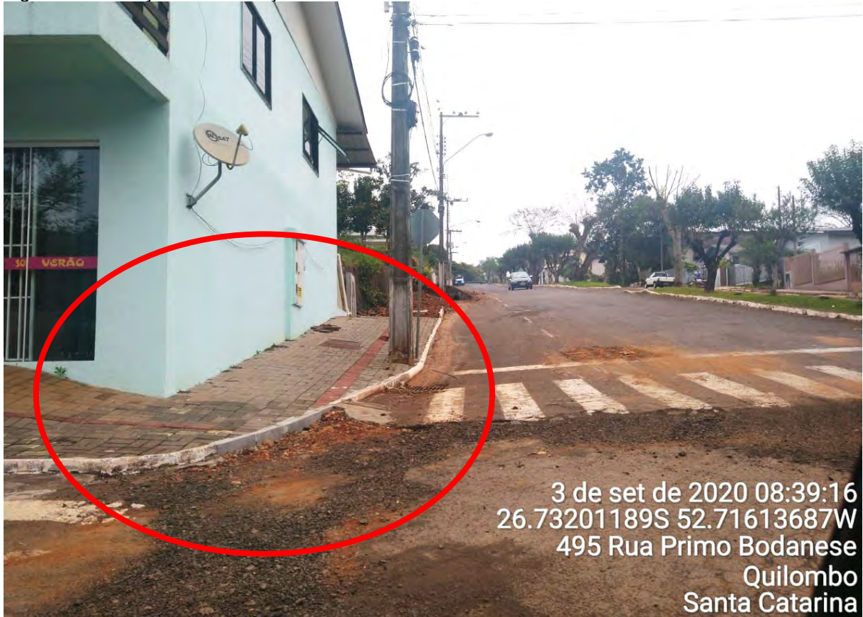
Figura 41 - Situação da sinalização tátil e de alerta na Rua Primo Bodanese.
