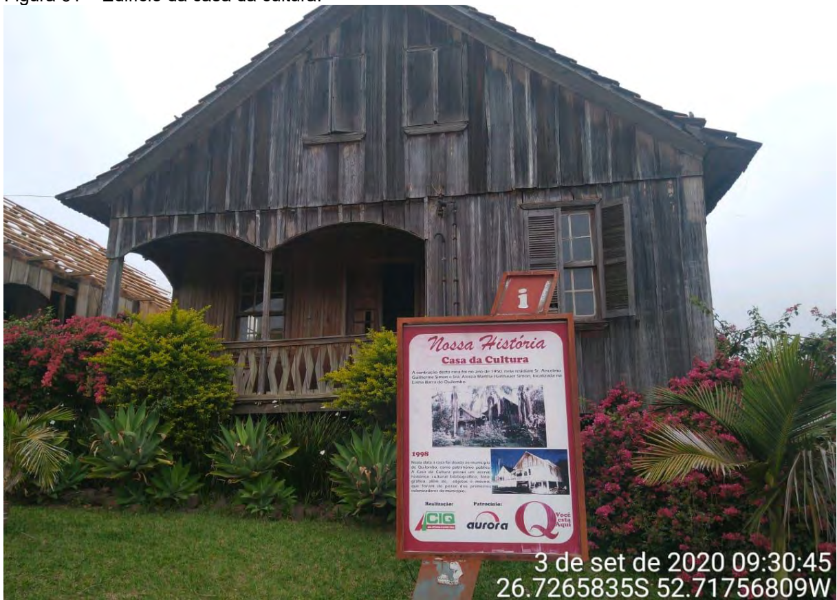
Figura 61 – Edifício da casa da cultura.
