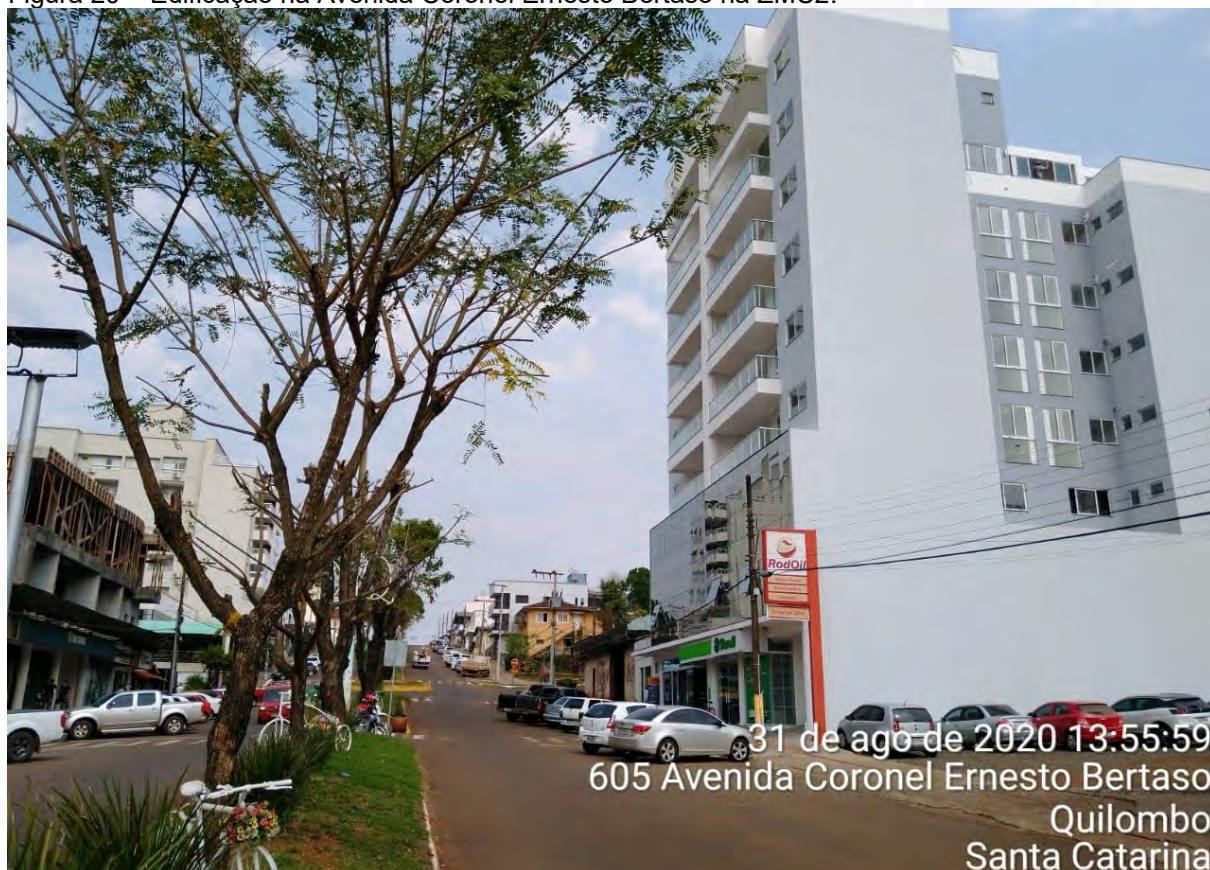
Figura 20 – Edificação na Avenida Coronel Ernesto Bertaso na ZMC2.
