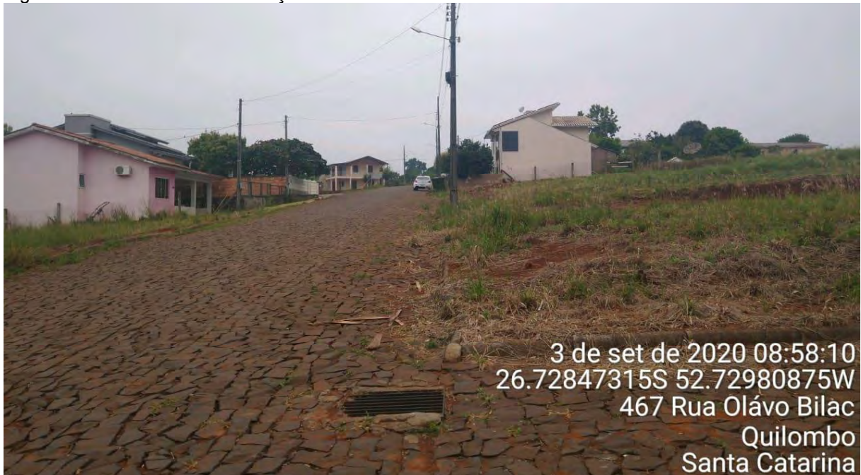
Figura 45 – Ausência de sinalização horizontal e vertical na Rua Olavo Bilac.
