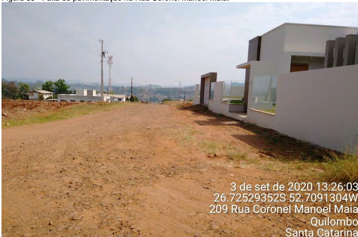
Figura 39 - Falta de pavimentação na Rua Coronel Manoel Maia.
